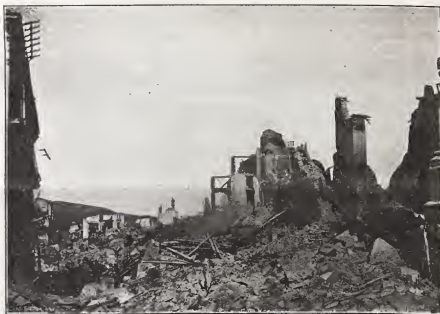
MESSINE. — Rue Garibaldi.
